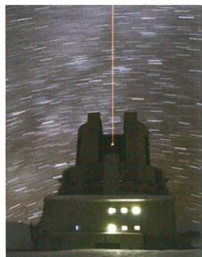
▶補償光学用レーザービームを放つすばる望遠鏡
